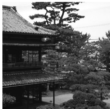
賣日館 1887年竣工 伊勢市に移管
